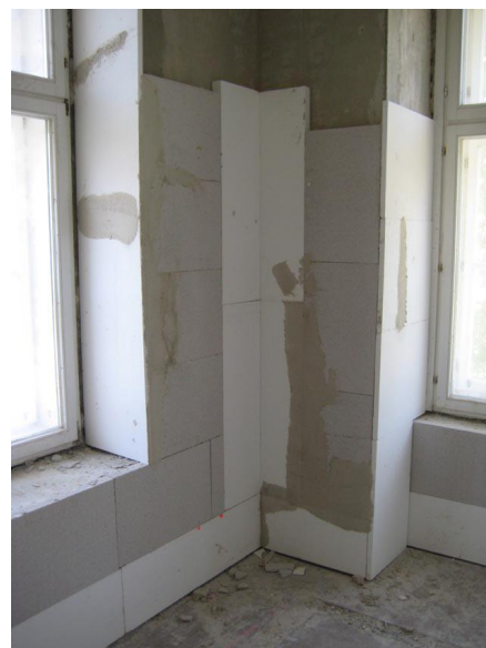
Innendämmung mit Ytong Multipor
