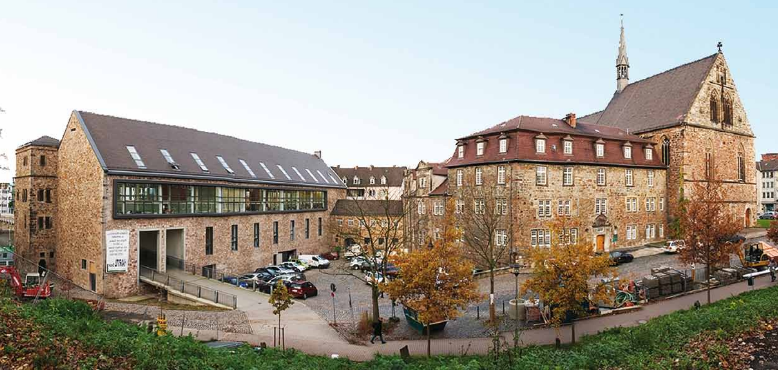
Renthof in Kassel: Sanierung eines denkmalgeschützten Gebäudes zu einem funktionellen Büro-/Geschäftshaus und Dental-Labor
