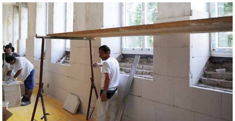
Das „Loft11“ in der Wiener Engerthstraße wurde mit der YTONG Multipor Mineraldämmplatte innenseitig energetisch optimiert.
