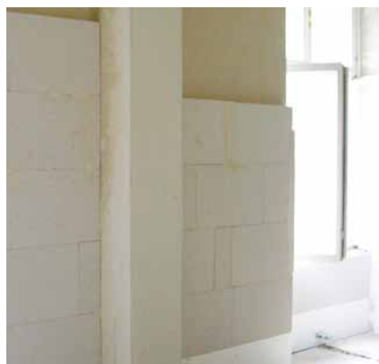
Bei der energetischen Sanierung des Klosters Kalksburg kam YTONG Multipor als Innendämmung der Außenwände zum Einsatz.
