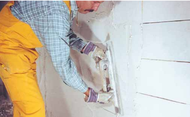
Beim Aufziehen auf die richtige Schichtstärke achten.
