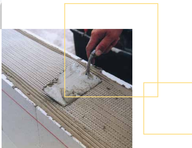
Die Bewehrungseinlage Armyt wird bei der Verarbeitung mit YTONG Planblockmörtel als Parapetarmerung eine volle Reihe unter der Fensteröffnung eingearbeitet.
