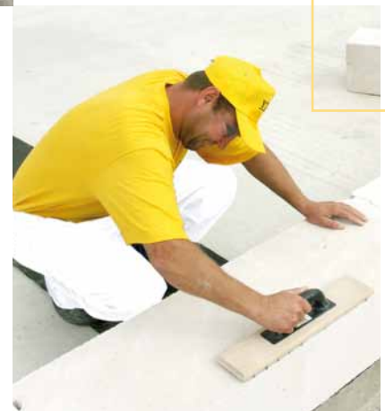
Der beim Arbeiten mit dem Schleif- oder Raspelbrett anfallende Schleifstaub muss abgekehrt werden, da er sonst eine Trennschicht zum Mörtel bildet.
