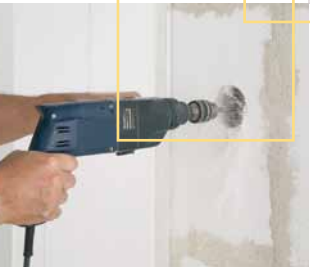
Die Löcher für Schalterdosen können gefräst oder gebohrt werden. Löcher für Befestigungen bohrt man am besten mit einem Metallbohrer.
