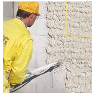
3. Schritt Den Außenputz in zwei Schichten auftragen, zuerst in 10 mm und anschließend in 3 mm. Für Anschlüsse, z.B. Rost, wird in das obere Drittel der Grundsicht eine Gewebeeinlage eingebettet.
