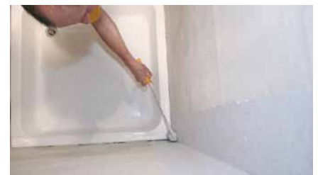
YTONG Wände können ohne zu verputzen direkt gefliest werden. Grundsätzlich ist auf die staubfreie Wandfläche vollflächig eine Lage Fliesenkleber als Grundschicht dünn aufzutragen. In Feuchtebereichen (z.B. Duschkabine) ist eine Dichtmasse aufzuziehen. Darauf folgen das Auftragen des Fliesenklebers mit der Zahnpachtel und die Verfliesung. Eine eventuelle Gewebeeinlage erfolgt in der Grundschicht.
