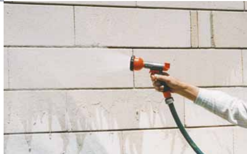
2. Schritt Vornässen mit Schlauchbrause (Aufbrennsperre!)
