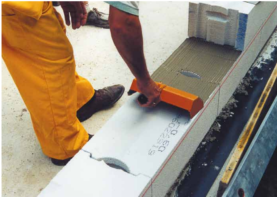
Der YTONG Planblockmörtel wird mit der YTONG Plankelle aufgetragen. YTONG Verbundsteine (Bild) werden nur in der Lagerfuge vermörtelt.
