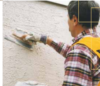
3. Schritt Den Außenputz in zwei Schichten auftragen, zuerst in 10 mm und anschließend in 3 mm. Für Anschlüsse, z.B. Rost, wird in das obere Drittel der Grundsicht eine Gewebeeinlage eingebettet.
