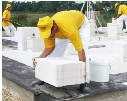
Die Basis für massive Wände: Feuchtigkeitsisolierung aufbringen und anschließend Niveaueausgleich mit Kalkzementmörtel herstellen.
