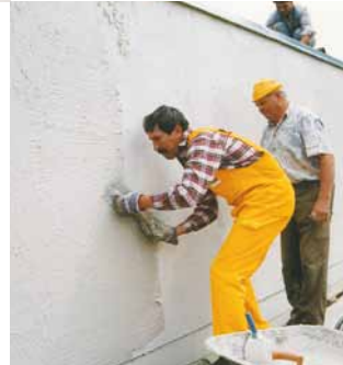
4. Schritt Nach 24 Stunden wird die Strukturschicht (3mm) aufgezogen und verrieben. Dabei gilt: Sorgfältig und gewissenhaft statt im Eiltempo!
