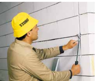
Installationsleitungsschlitze werden mit einer Fräse oder dem YTONG Rillenkratzer hergestellt.
