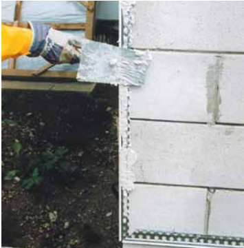
1. Schritt Eckenschutz- und Sockelprofile aufbringen.
