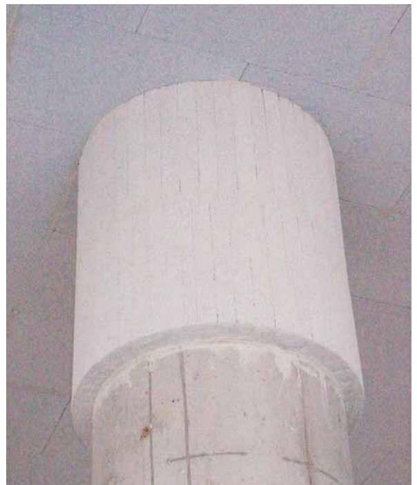
Sturzbekleidung mit Wandanschluss
