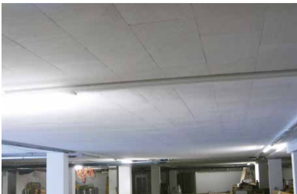
Tiefgaragendämmung im Austria Trend Hotel Fieberbrunn
