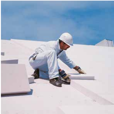
YTONG Multipor Mineraldämmplatte als Steildachdämmung
