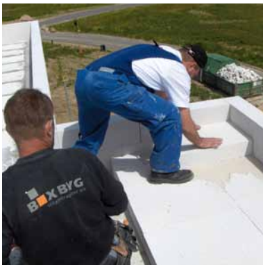
YTONG Multipor Mineraldämmplatte als Flachdachdämmung (mit und ohne Gefälle)
