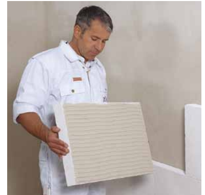
Anschließend wird die YTONG Multipor Mineraldämmplatte einfach auf die Wand geklebt.
