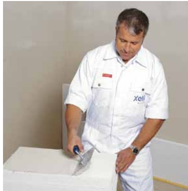
Der Leichtmörtel wird mit der Zahntraufel vollflächig auf die Platten aufgetragen.
