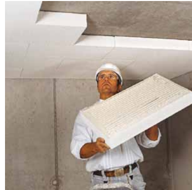
Massive Deckendämmung: leichte Verarbeitung über Kopf. Oberflächen bei Bedarf streichen oder mit gewebe-armiertem Putz versehen. Sicherheit durch nicht brennbares Material.
