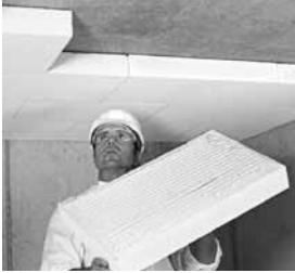
Vollflächige Verklebung der Platten bei der Deckendämmung
