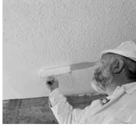
Gestaltung der gedämmten Decke durch handelsübliche Anstriche
