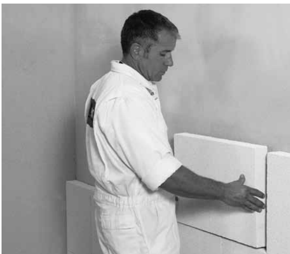
Einschwimmen der YTONG Multipor Mineraldämmplatten im Kleberbett
