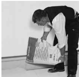
Fehlstellen mit Ausgleichschüttung auffüllen
