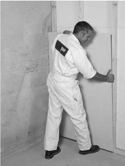
FERMACELL Gipsfaser-Platten auf Holzlatten als Trockenputz
