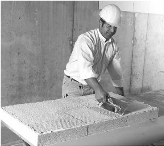
Auftragen von MULTIPOR Leichtmörtel mit der Zahntraufel
