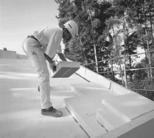
Mehrlagige Verlegung der YTONG Multipor Mineral- dämmplatten
