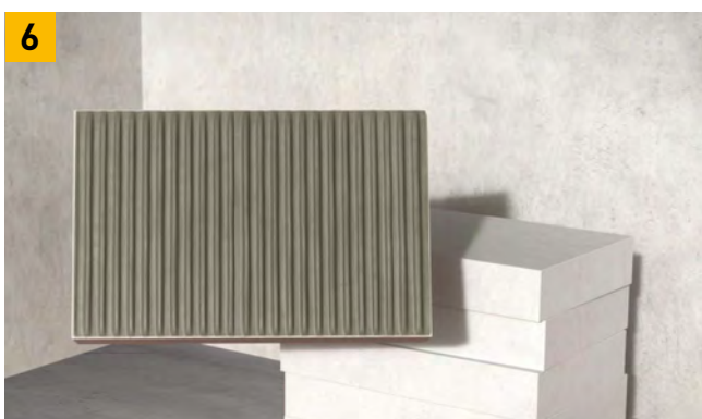
6 ExSal Therm Leichtmörtel auf Dämmplatte vollflächig auftragen.
