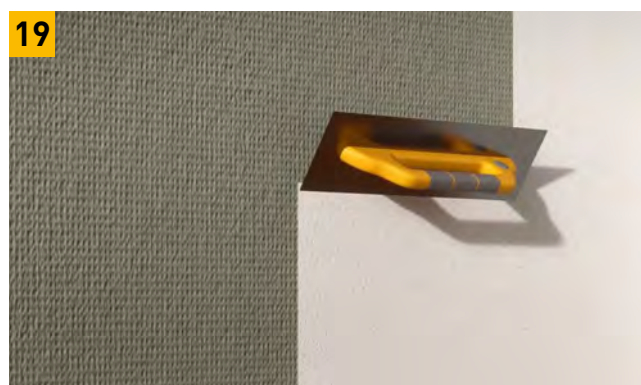
19 Multipor Kalkglätte als Oberputz dünn-schichtig (2 mm) auftragen (porenfüllend).
