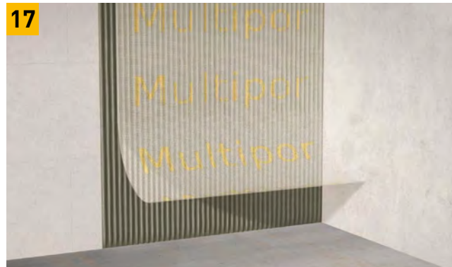
17 Armierungsgewebe auflegen. Die Bahnen mit ca. 10 cm Überlappung verlegen.
