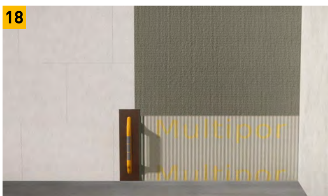
18 Armierungsgewebe ins obere Drittel des ExSal Therm Mörtels einbetten (Armierungsschicht 5 mm dick).
