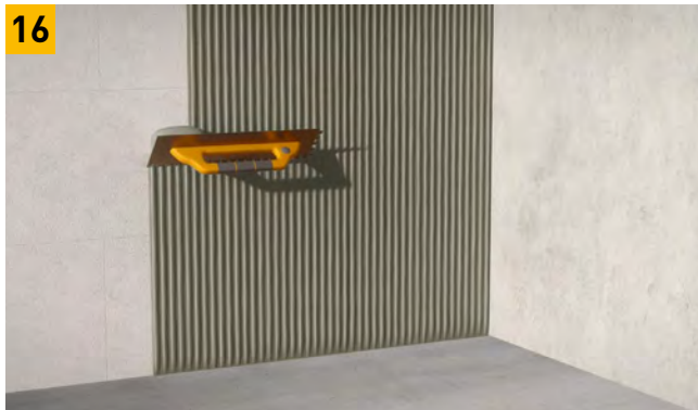
16 ExSal Therm Leichtmörtel mit 12 mm-Zahntraufel aufziehen.
