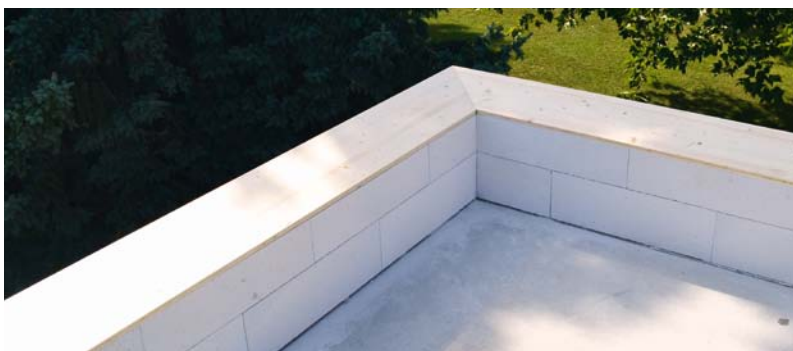
Fertig für die Verblechung!
