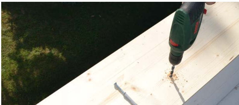
Die Unterlagsplatte mittels geeigneten Dübeln befestigen.
