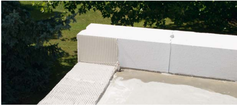
Attikasteine in das abgegliche Mörtelbett setzen.
