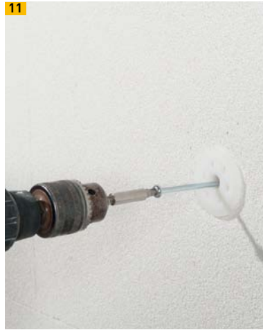
11 Dübel setzen
