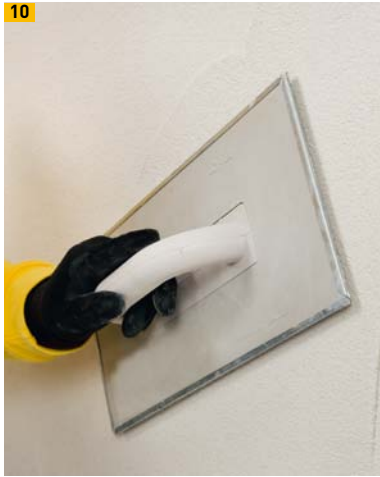
10 Beis Schleifen der Oberfläche
