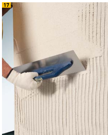
17 Armierungsgewebe einputzen
