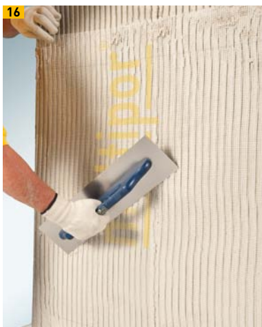
16 Armierungsgewebe einlegen
