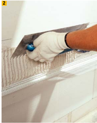
2 Sockelabschluss mit Gewebewinkel
