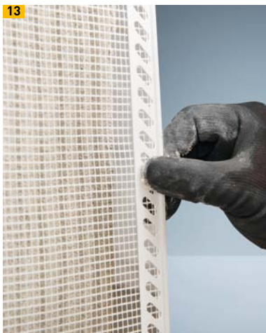
13 Gewebeeckprofil an Außenecke
