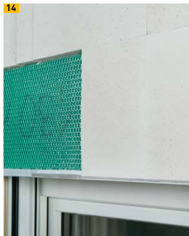
14 Überdämmung Raffstorekasten
