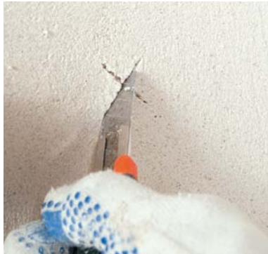
Vorsichtiges Einschlitzen der Putzschale
