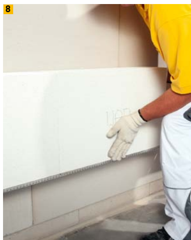
8 Multipor Mineraldämmplatte andrücken und einschwimmen
