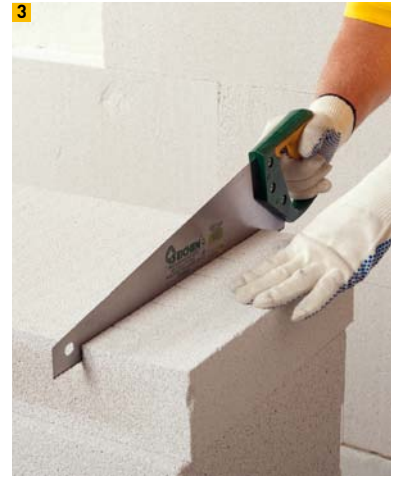
3 Schneiden der Mineraldämmplatte
