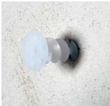
Setzen des Fischer Spiraldübels
