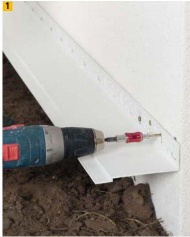
1 Sockelschiene, gedübelt
