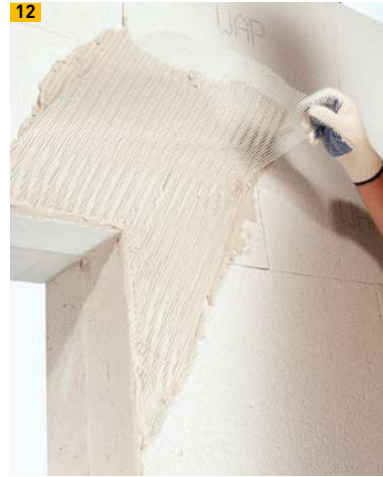
12 Armierungsgewebe über Fensteröffnung
