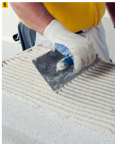
5 Multipor Leichtmörtel auf Dämmplatte auftragen
