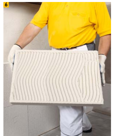
6 Vollflächig aufgetragener Mörtel
