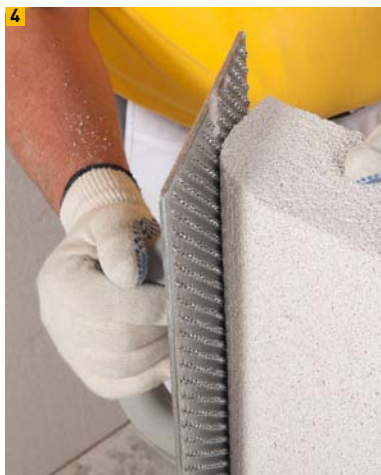
4 Anpassung der Dämmplatte
