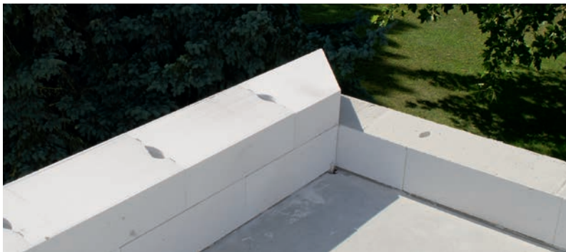
Abgeschrägte Attikasteine aufsetzen und im Eckbereich auf Gehrung schneiden.
