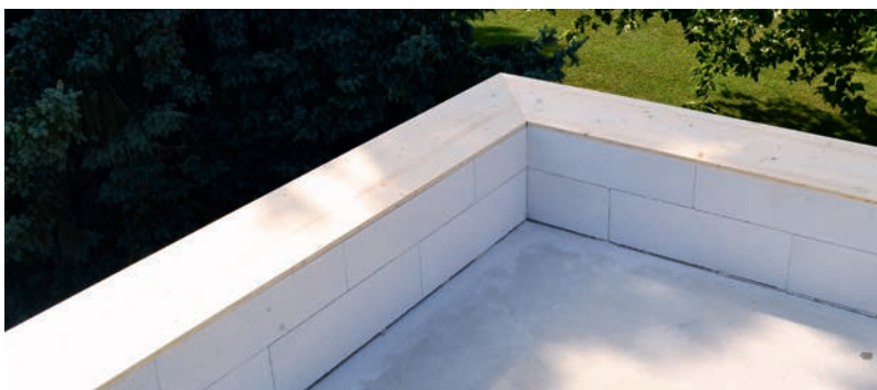
Fertig für die Verblechung!
