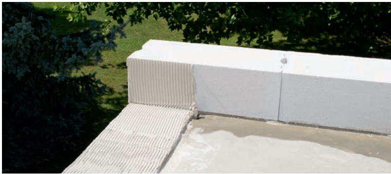
Attikasteine in das abgegliche Mörtelbett setzen.
